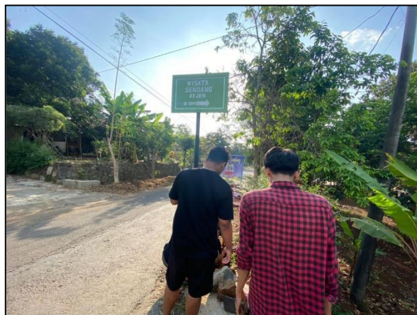
Gambar 11 Pemasangan Plang Penunjuk Wisata
