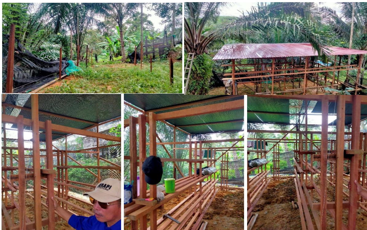
Gambar 6. Proses Pembangunan Kumbung Jamur Tiram
