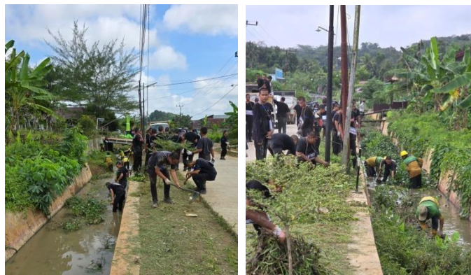
Gambar 6. Pembersihan Saluran Drainase Sumber: Dokumentasi, 2024
