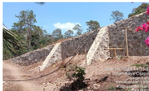
Gambar 3. TPT Jalan Lingkungan Dusun 3 Desa Jangkurang
