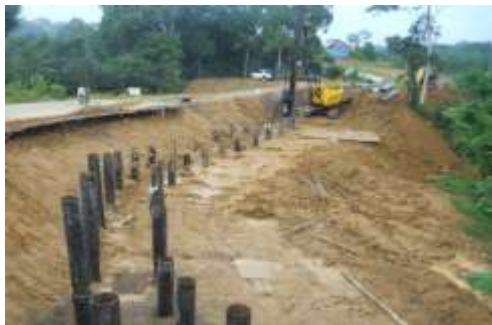
Pemancangan Tiang Pancang
