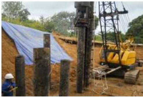
Pemancangan Tiang Pancang
