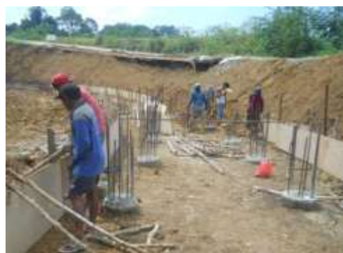
Pemasangan Bekisting
