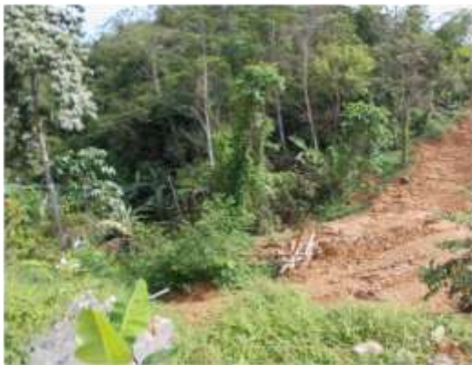
Situasi Lokasi Longsoran
