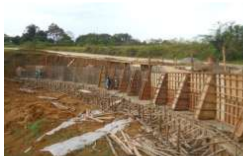
Pemasangan Bekisting
