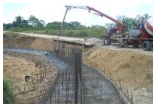
Pengecoran
