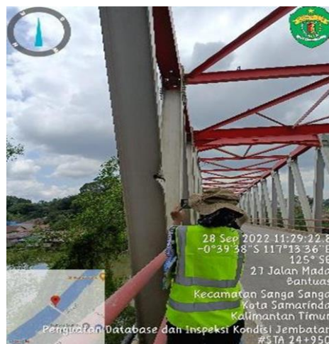
Gambar 9. Batang Diagonal Profil Baja Sobek
