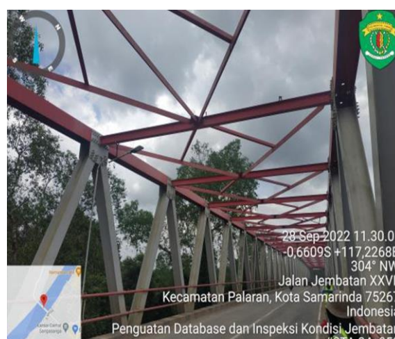
Gambar 6. Tiang Lampu Penerangan Patah
