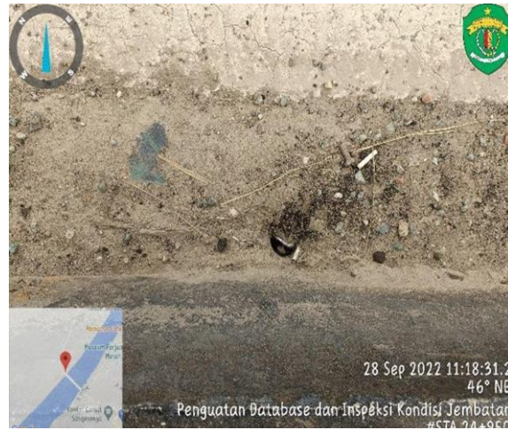
Gambar 7. Pipa Cucuran Tersumbat
