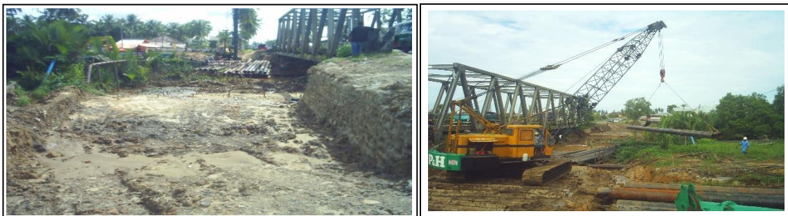
Pembersihan lokasi abutment di daerah jembatan Batakan III
