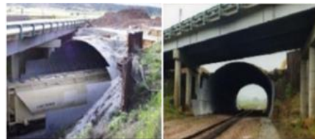
Gambar 2. Beton busa sebagai timbunan diatas jembatan
