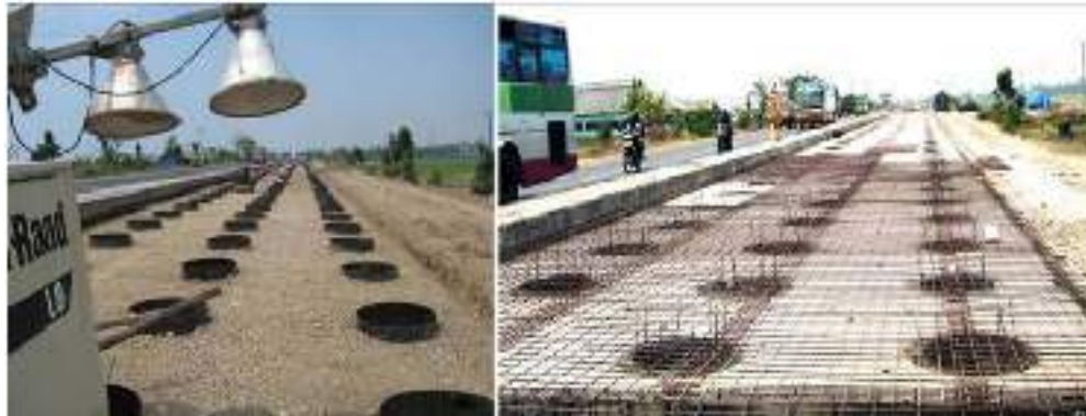
Gambar 2. Aplikasi lapangan sistem Cakar Ayam Modifikasi (CAM)
