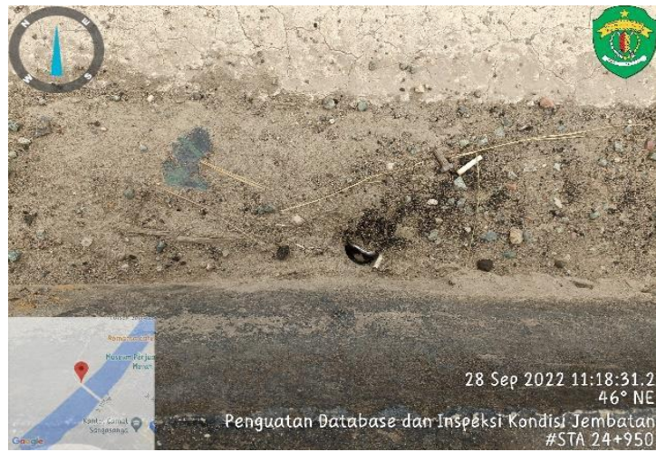
Gambar 7. Pipa Cucuran Tersumbat
