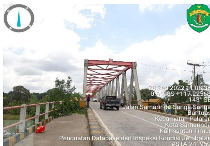
Gambar 1. Arah lalu Lintas Memasuki Jembatan
