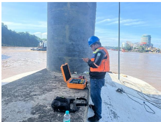
Gambar 6. Pemasangan Prisma Tempel untuk Pemantauan Vertikal
